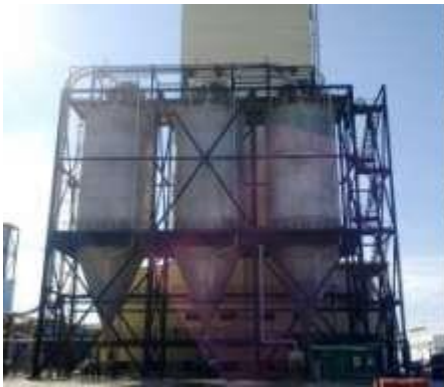
Figure 22 : Silos de stockage de la poudre
