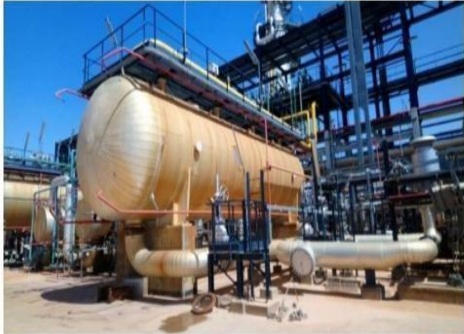
Figure I.6: Séparateur diphasique
