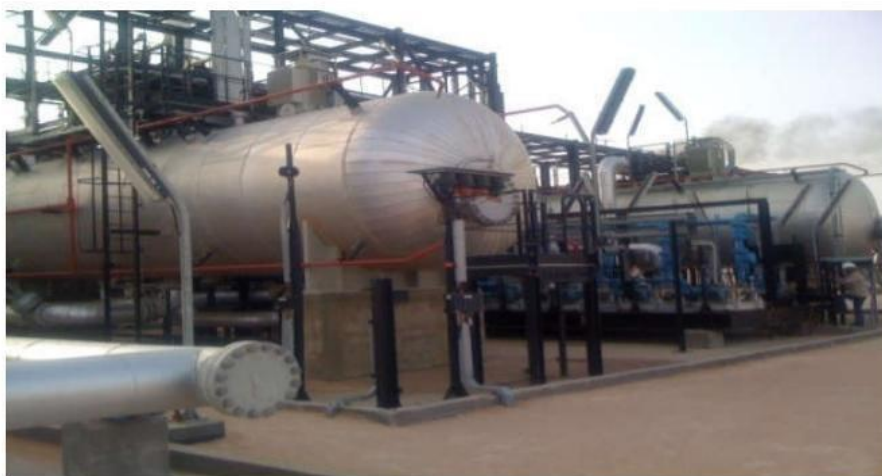
Figure. I.7 : Dessaleur 1er et 2ème étage
