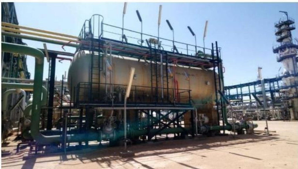
Figure I.4: Séparateur tri phasique
